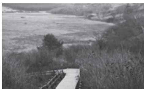
改修工事が進む八島湿原の木道
